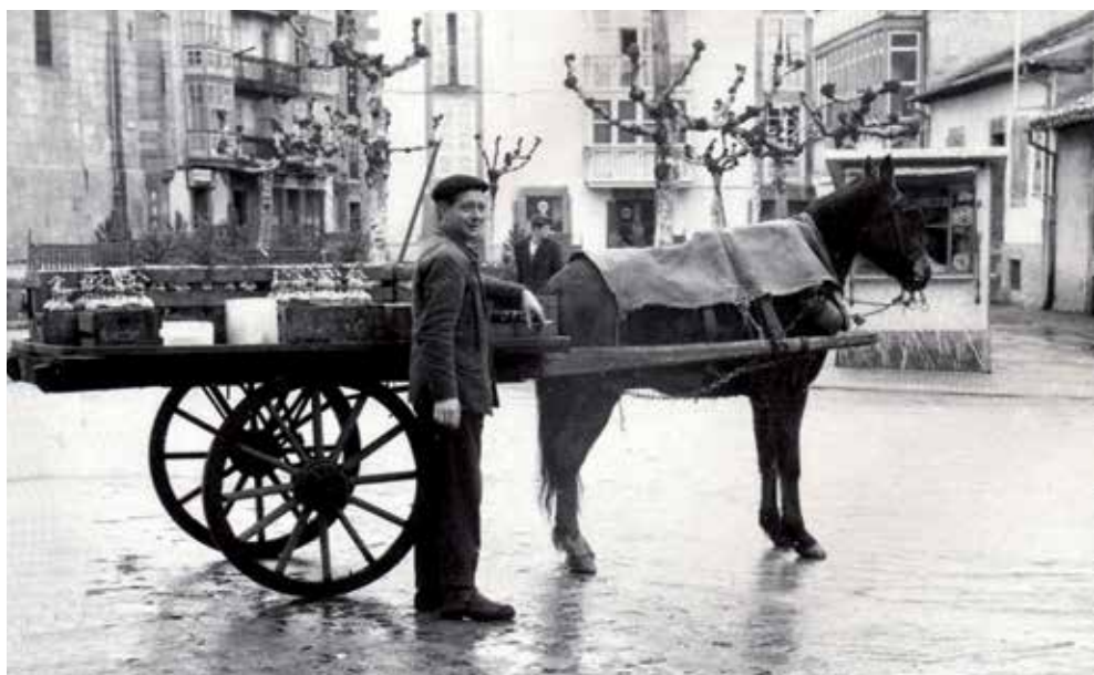
Foto Antigua (Parque Iglesia)
